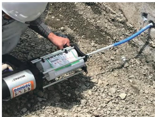
▲ボンドトップPRO-WGカートリッジタイプでのエアーガン充填状況
