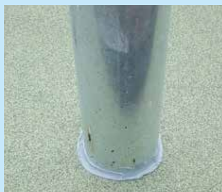
▲隙間処理状況
