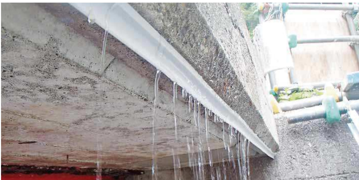
▲構造物底にウォーターカッター設置状況
