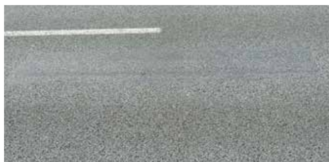
▲施工後約6ヶ月の状況
