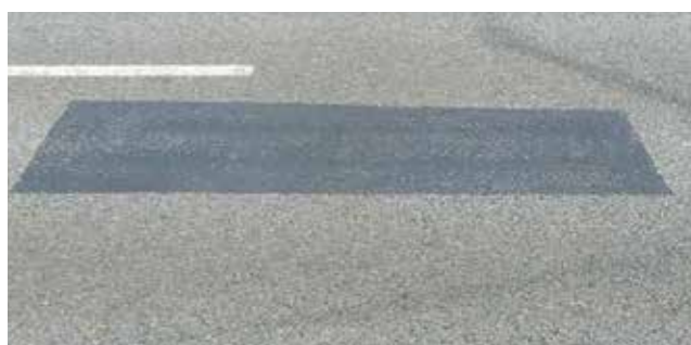
▲施工直後の状況
