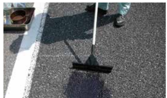
2.ゴムベラ等で表面に広げて浸透させます (標準使用量=2.0kg/m 2 )
