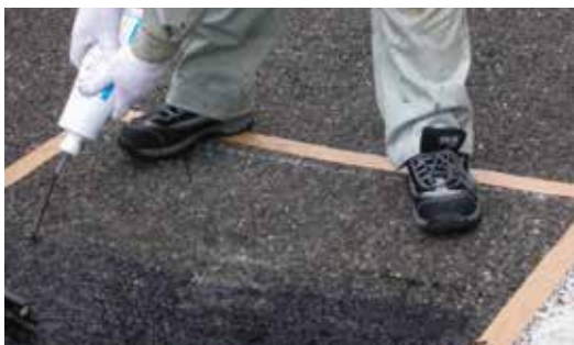
1.主剤と硬化剤を混合し、施工面上へ吐出します
