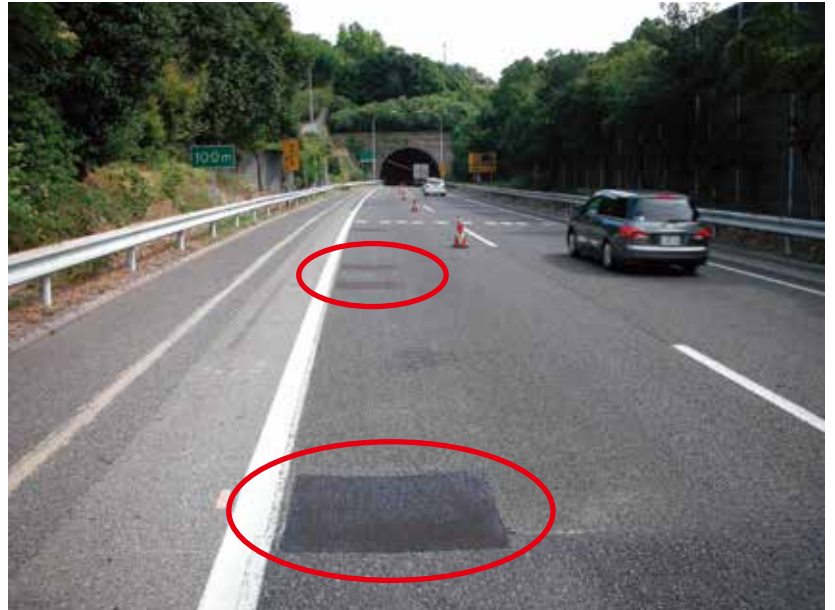
▲排水性舗装のひび割れ補修状況
