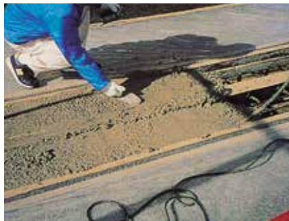
▲コンクリート打設状況
