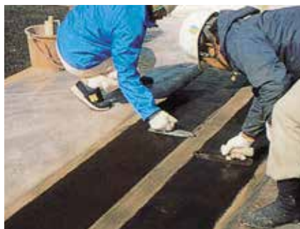
▲表面処理材仕上げ状況
