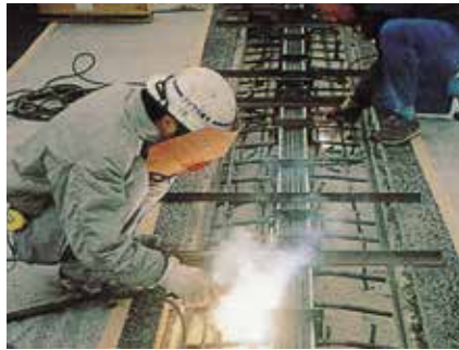
▲配筋溶接状況
