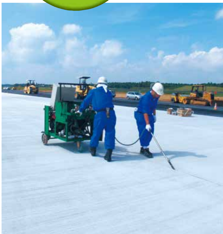
▲自動混合機械での注入状況(空港エプロン目地注入)
