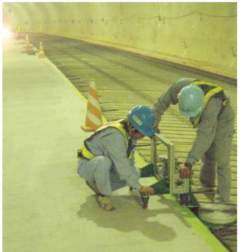
▲キッスシーラー1401(専用機械使用)貼り付け状況
