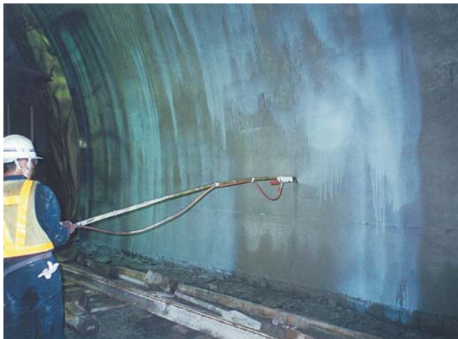
▲トンネルアーチ部へAA塗布状況
