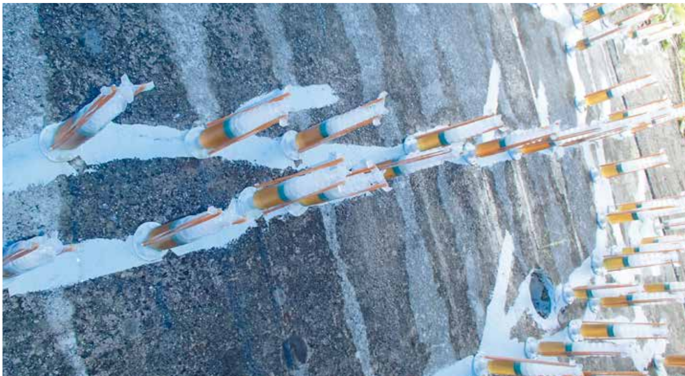
▲擁壁のひび割れ部へのリハビリボンド注入状況
