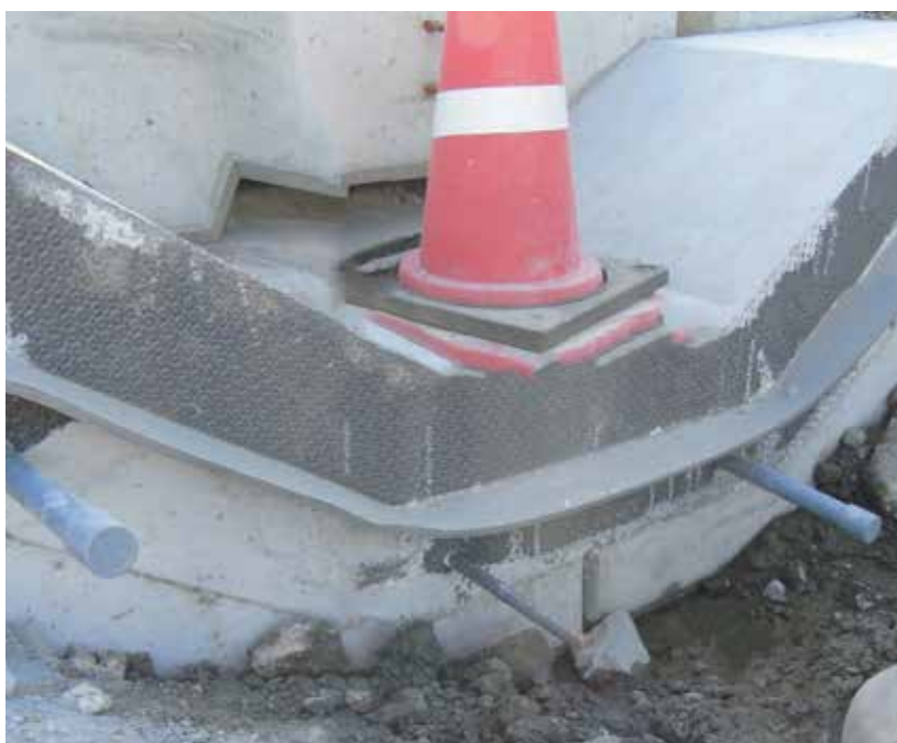
▲ダウエルバー設置状況
