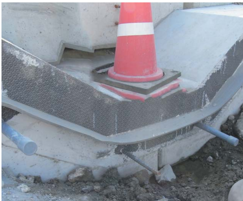
▲ダウエルバー設置状況
