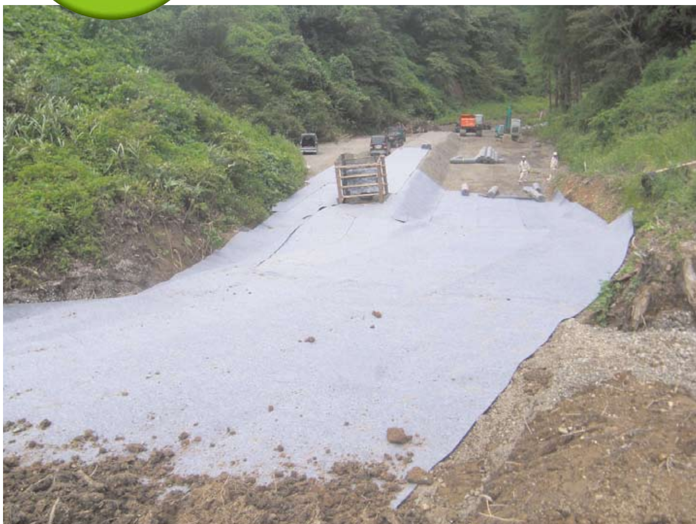
▲造成工事にキュアマットCCを使用
