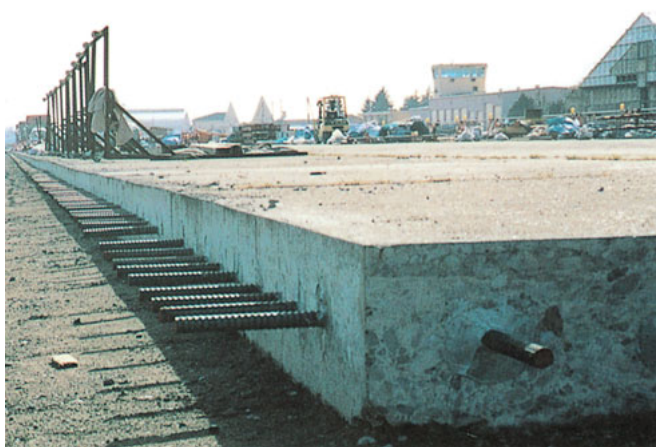
▲アンカーボルト固定にボントトップWG(A)使用
