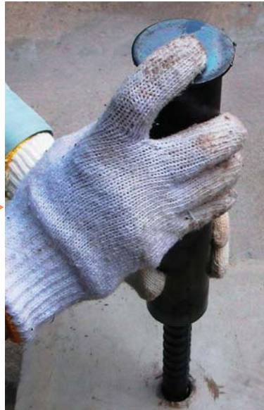
②穴に位置を合わせてアンカー筋にワンキャップをかぶせます。
