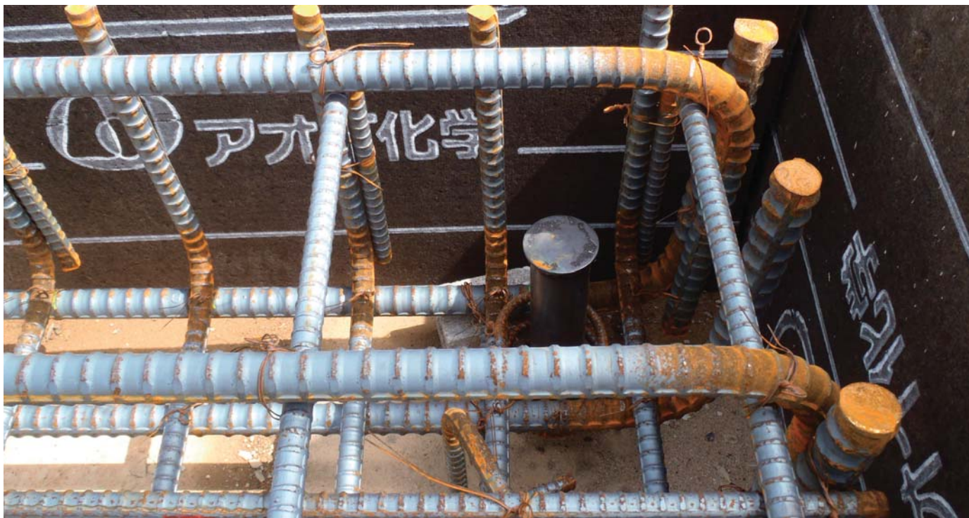
▲踏掛板アンカーの防食充填キャップに使用状況
