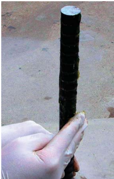
①アンカーバーにグリスを塗布します。
