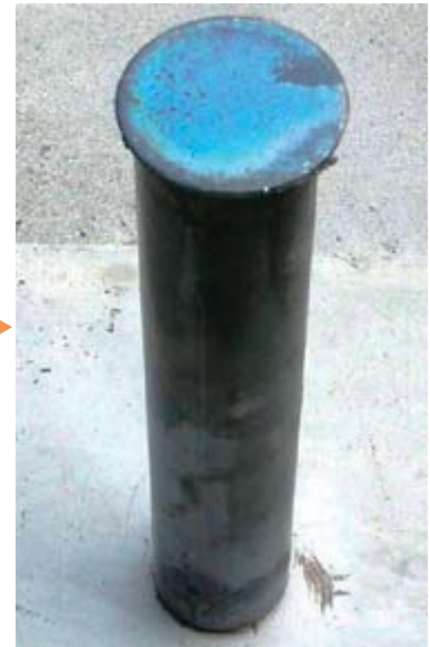
③施工完了。
