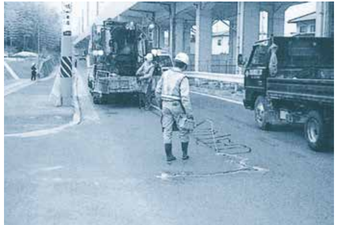
▲仕上げ メンデシールへ石粉水の散布
